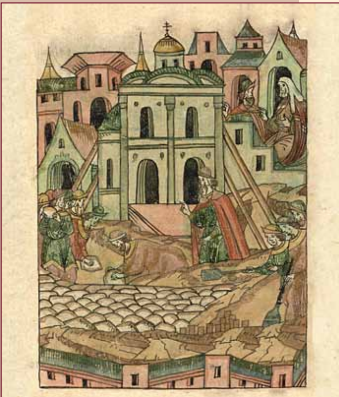
▲ Закладка фундамента Успенского собора Кремля вокруг ветхого старого здания в 1472 г.
